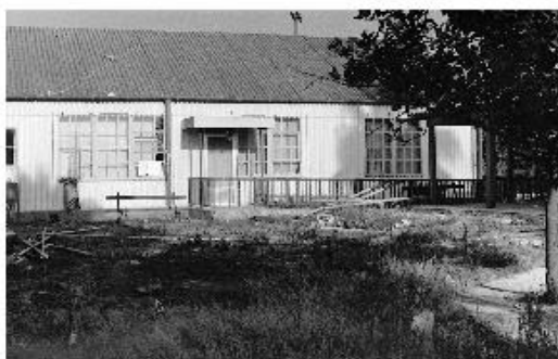
Οργανισμός Δημόσιας Αντίληψης Ζακύνθου - Προκατασκευασμένο κτίριο
